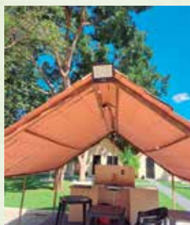
Instalação de refletores em Aruanã
