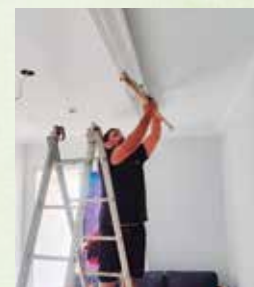
Manutenção elétrica e troca das lâmpadas em Caldas Novas
