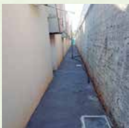
Novo calçamento entre os chalés e nos fundos das unidades, em Aruanã
