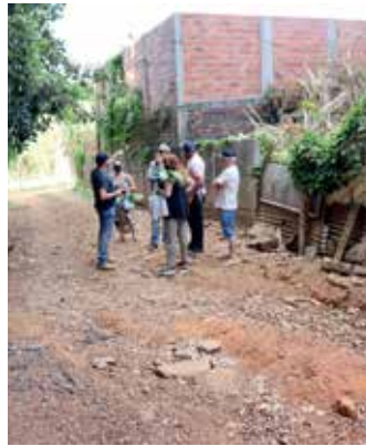
Erosões, muros deteriorados e árvores doentes
