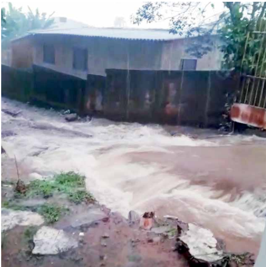
Enxurrada invadindo e destruindo ainda mais a entrada da chácara que havia recebido a terraplenagem
