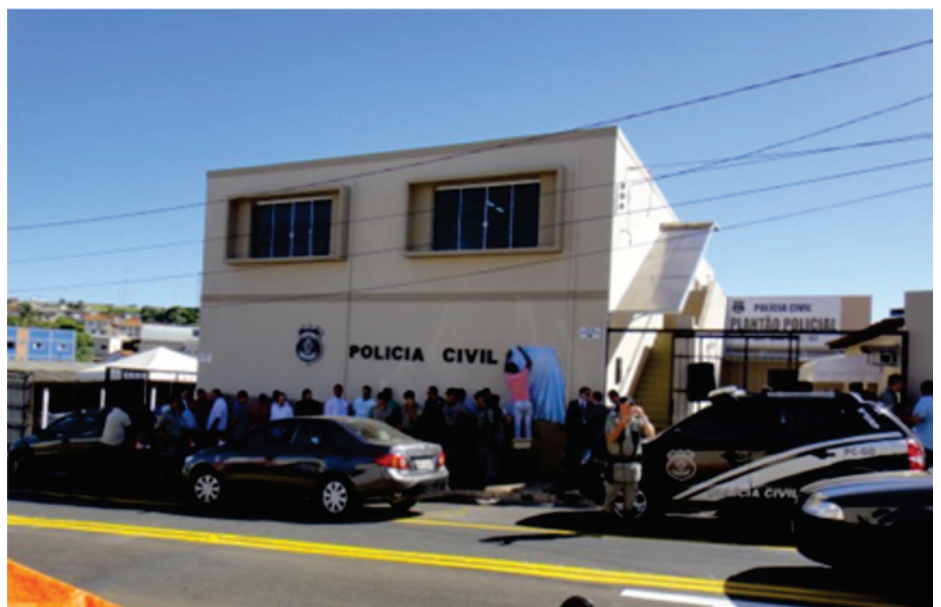
Fachada do 1º Distrito Policial e da Central de Flagrantes de Catalão
